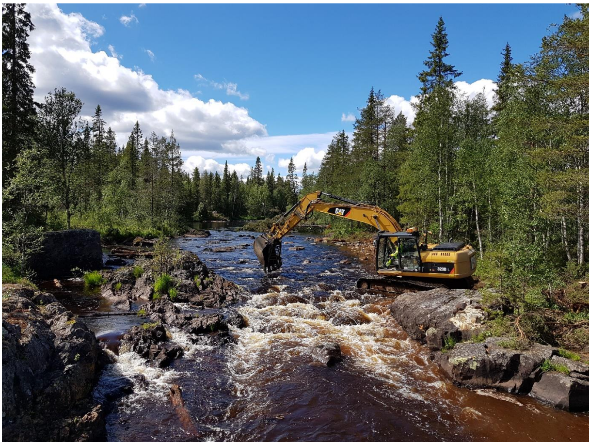
Bild från pågående restaureringsarbete högt upp i Lögån i Åsele kommun sommaren 2019.
